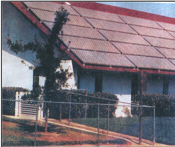
Εγκατάσταση Φ/Β πλαισίων σε στέγη για αυτοδύναμη κάλυψη των ενεργειακών αναγκών. Μία συνήθης κατοικία απαιτεί ημερησίως ηλεκτρική ενέργεια ίση με 5 kWh, περίπου. 57
