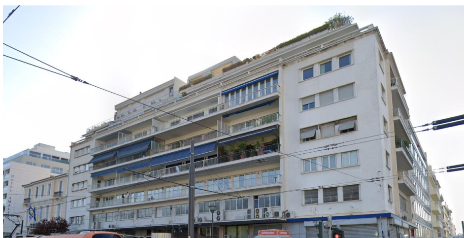
Εικ.09. Άποψη από το νέο συγκρότημα πολυκατοικιών που κατασκευάστηκε στη Λεωφόρο Αμαλίας 2-4 και Όθωνος.
