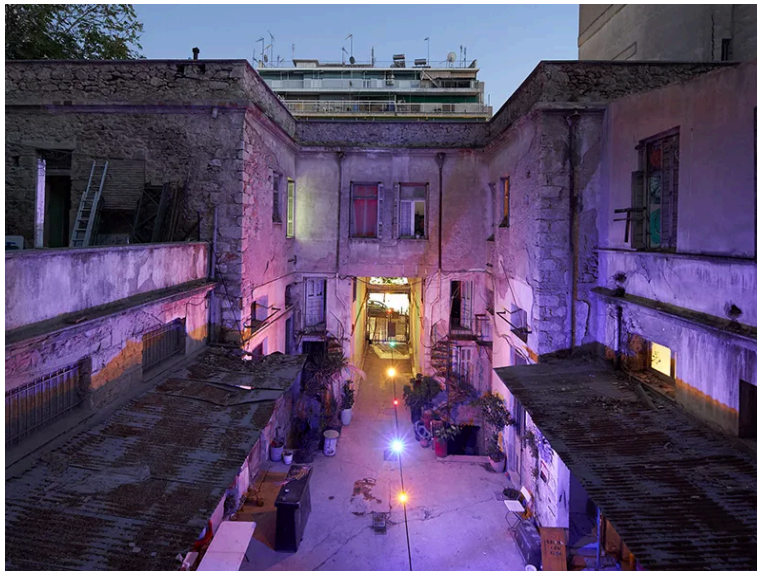
Κτίριο Κεραμεικού 28, Αθήνα. Αυλή.
