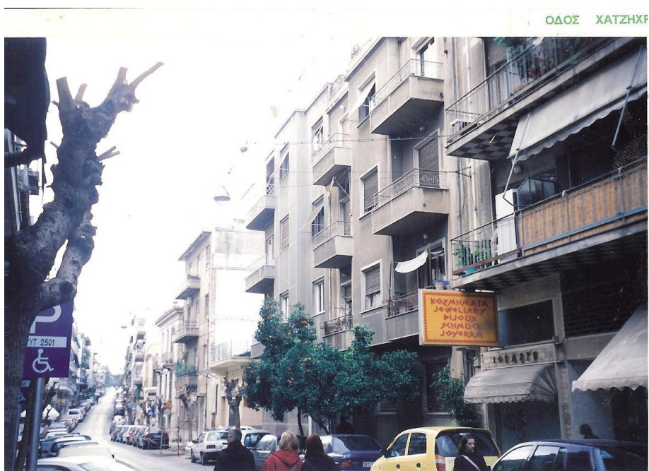
Εικ.4 Οδός Χατζηχρήστου 2003. Οι πολυκατοικίες της δεκαετίας του 1960 πριν την κατεδάφιση. Λήψη από ΝΑ. (Πηγή: φωτογραφικό αρχείο κατοίκου Α.Β.)
