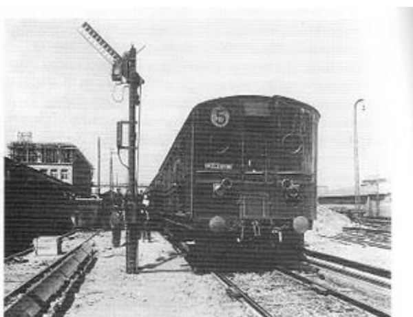
Ο σιρμός με προορισμό το Μοσχάτο, ενώ αναχωρεί από τον υπό ανέγερση νέο σταθμό του Γεραίου, το 1926
