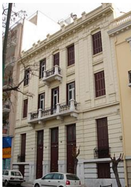
Εικόνα 36: Ιουλιανού 21 Τριώροφο εκλεκτικιστικό κτίριο
