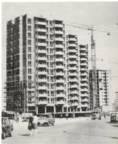
Εικόνα 7: Το Τείχος της πόλης υπό κατασκευή, 1973.
