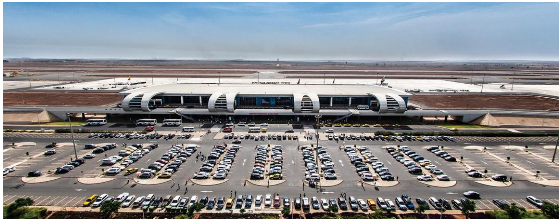
Εικόνα 7: Το διεθνές αεροδρόμιο Blaise Diagne στη Σενεγάλη
