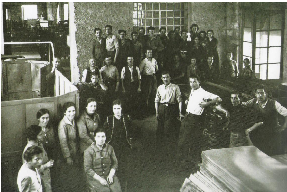
Εικόνα 21 Εργάτες και προσωπικό του εργοστασίου «Τρία Άλφα» σε ώρα ανάπαυσης. Μεταξύ τους διακρίνεται ο Σταύρος Στύλογλου. Πηγή : ΚΕ.ΜΙ.ΠΟ.
