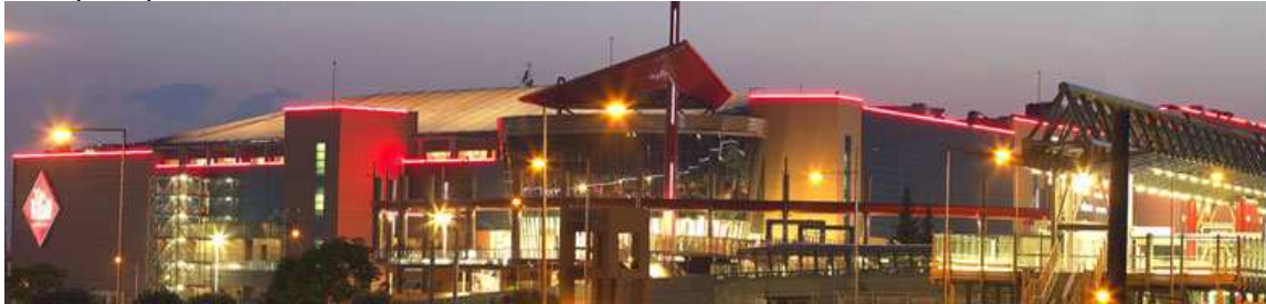
Εικόνα 10: Πανοραμική άποψη του The Mall Athens, όπως φαίνεται από το σταθμό του ηλεκτρικού
