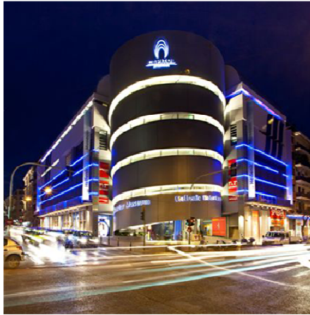
Εικόνα 18, 19: Άποψη της κεντρικής εισόδου και του εσωτερικού κήπου του Athenian Capitol
