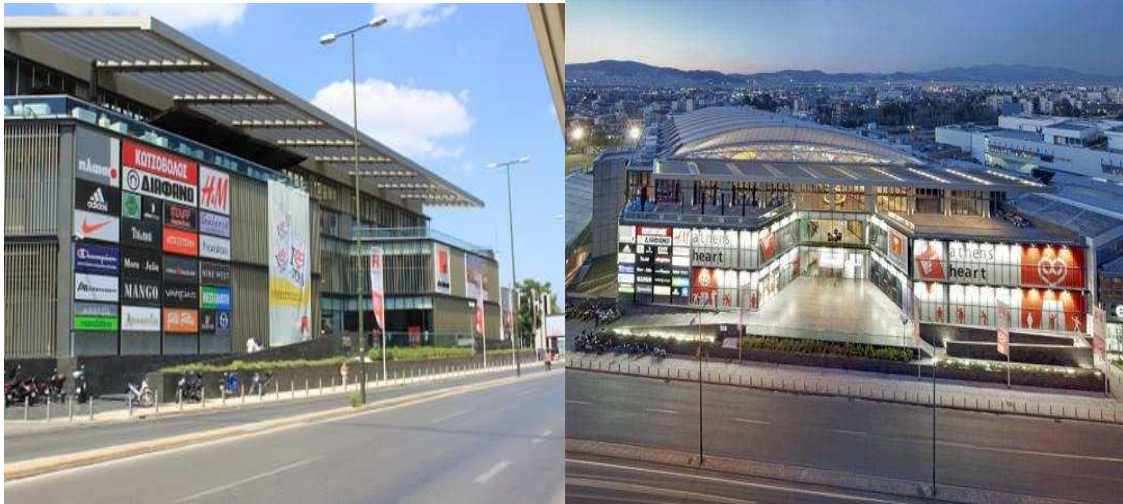
Εικόνα 13, 14: Είσοδος και γενική νυχτερινή άποψη του Athens heart από την οδό Πειραιώς
