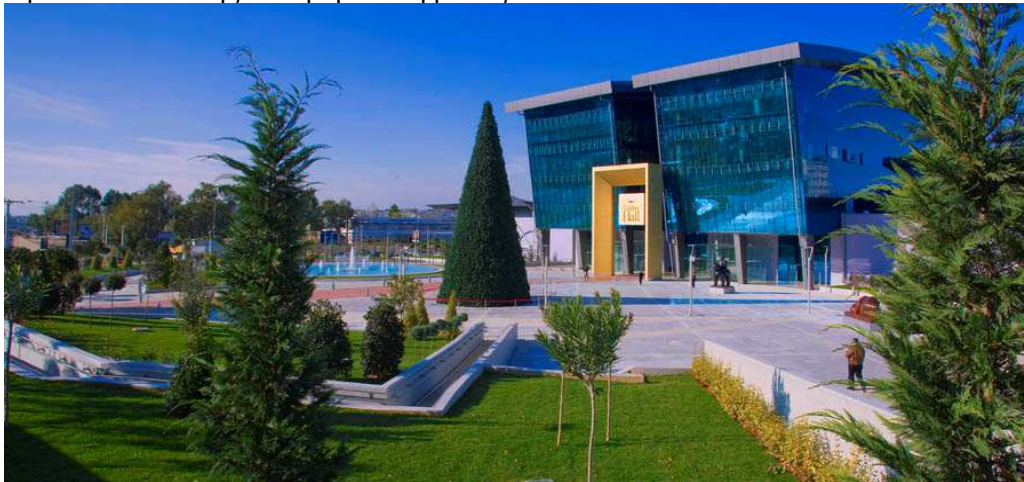
Εικόνα 12: Άποψη της πρόσοψης του Golden Hall και του περιβάλλοντος χώρου από την είσοδο επί της λεωφόρου Κηφισίας
