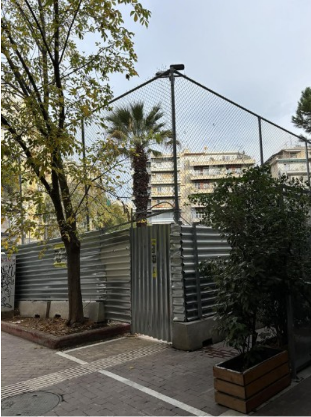
Figure 5: Φωτογραφία από το εργοτάξιο στην πλατεία Εξαρχείων (Πηγή: Προσωπικό Αρχείο)
