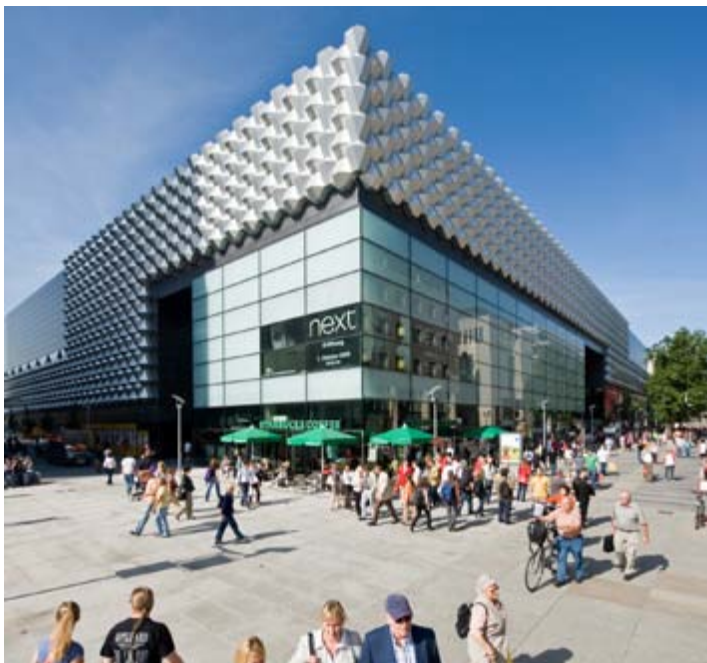
Εικόνα 11 : Centrum Galerie - Δρέσδη
