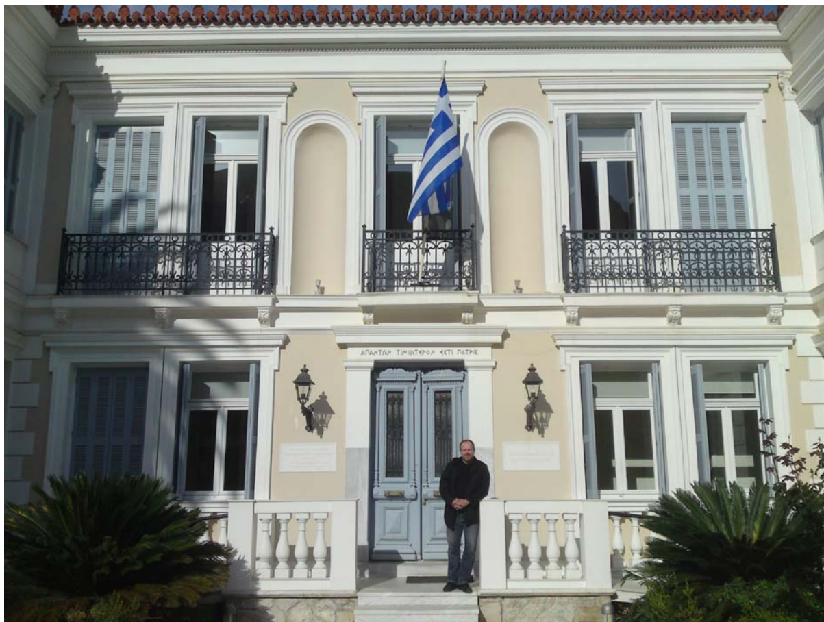
Φωτογραφία 2 : Νότια όψη
