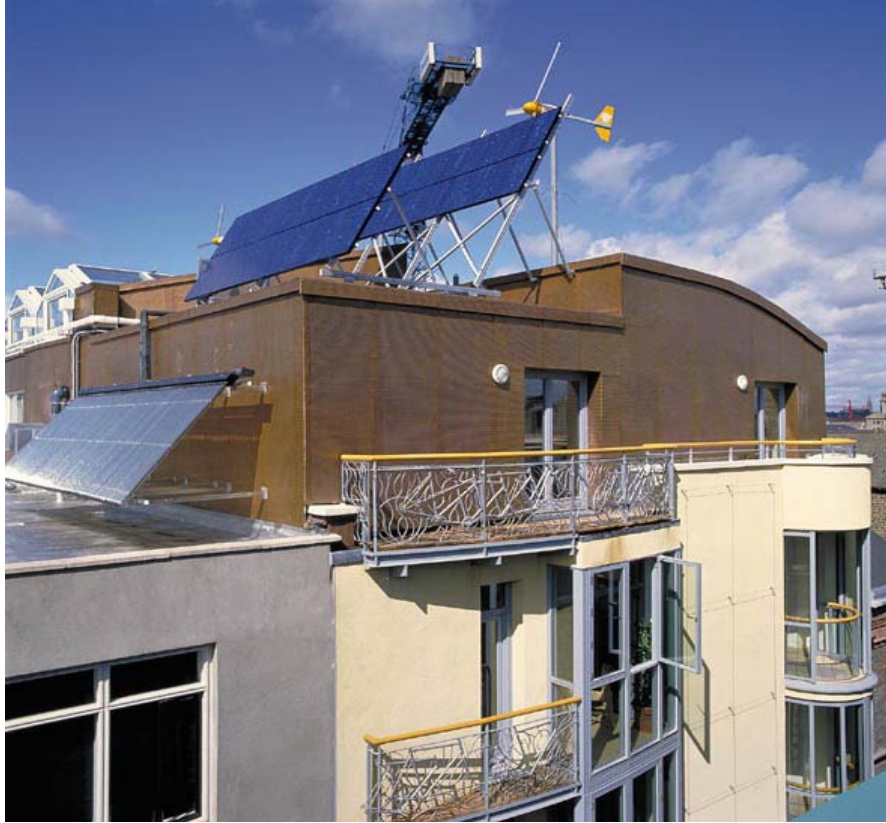
Εικόνα 1 : Το «Πράσινο Κτίριο» στο Temple Bar Δουβλίνο με τις ανεμογεννήτριες και τα φωτοβολταϊκά πάνελ στην οροφή. Πηγή http://www.paddi.net/images/green.htm
