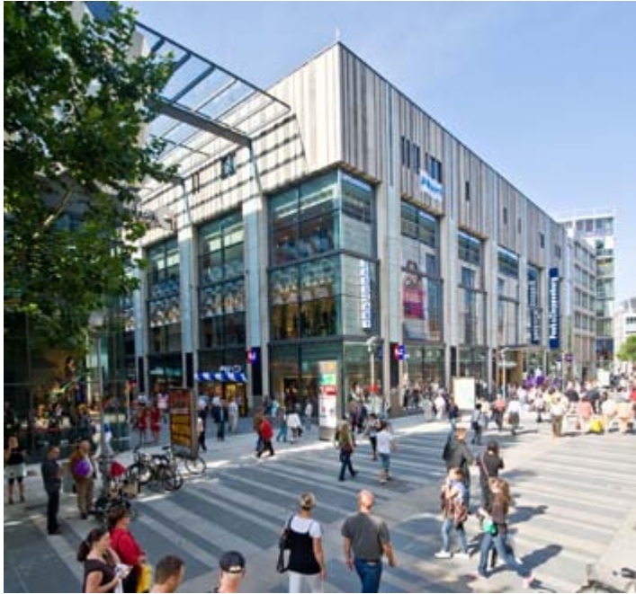
Εικόνα 10 : Centrum Galerie - Δρέσδη
