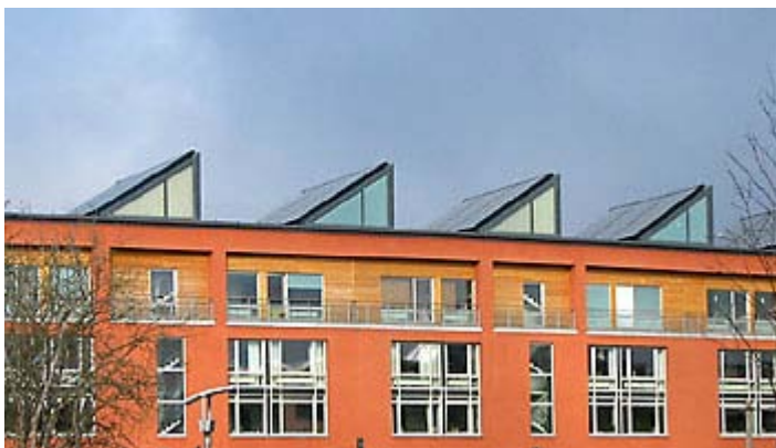
Εικόνα 3 : Το κτίριο Holmen στη γειτονιά Hammarby Πηγή : http://www.hammarbysjostad.se/
