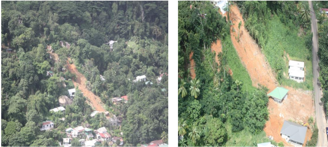
Φωτογραφία 55 Κατολίσθηση εξαιτίας του Κυκλώνα
