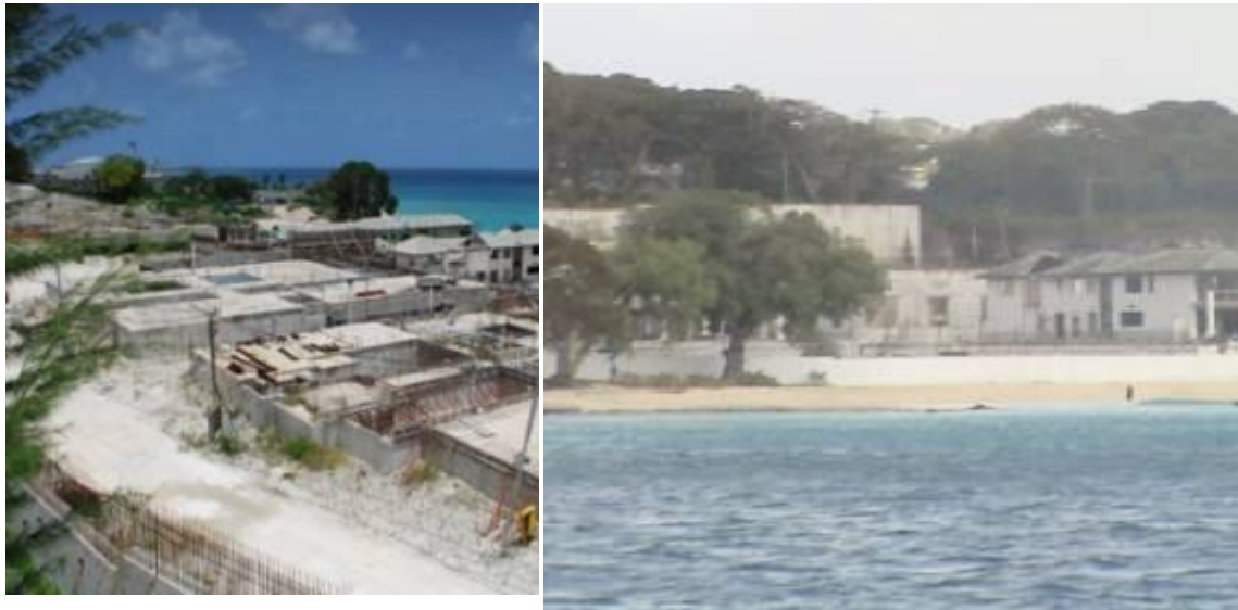
Φωτογραφία 34 Η Κατασκευή του Θέρετρου 901
