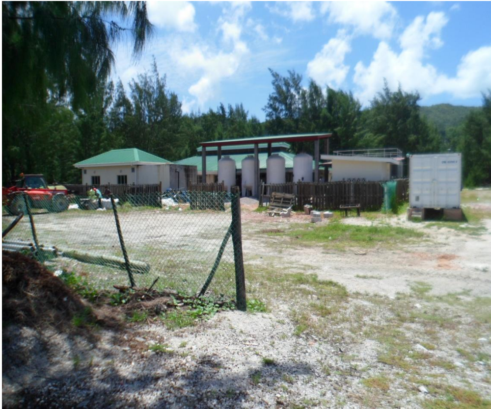
Φωτογραφία 52 Το Εργοστάσιο Αφαλάτωσης στο Νησί Praslin
