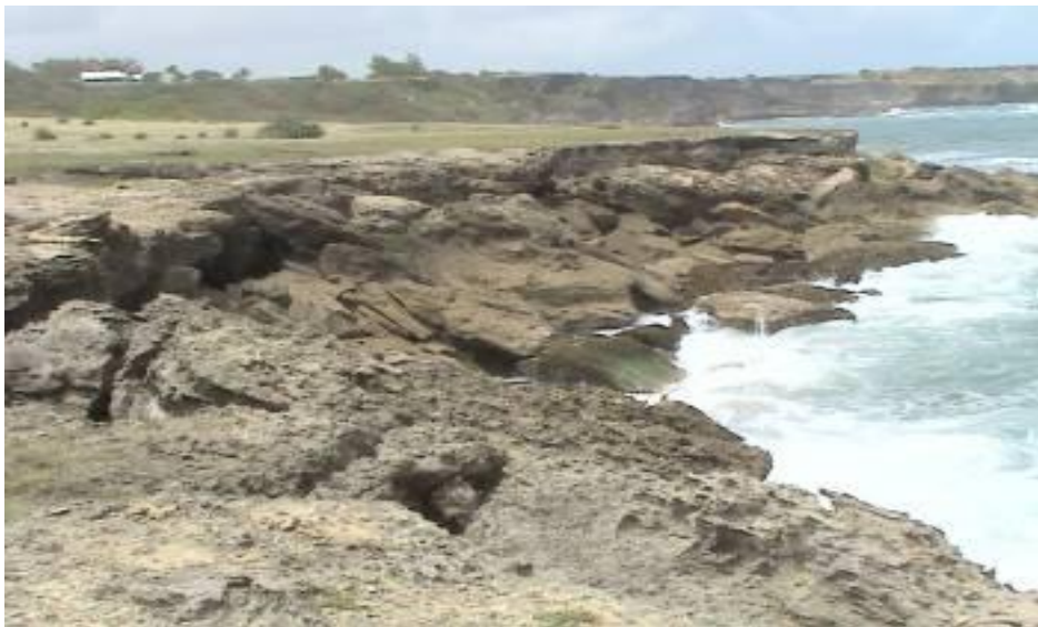
Φωτογραφία 37 Η Έντονη Διάβρωση στο Skeete's bay
