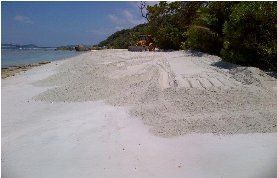
Φωτογραφία 64 Εμπλουτισμός Παραλίας για την Αποκατάσταση από τη Διάβρωση
