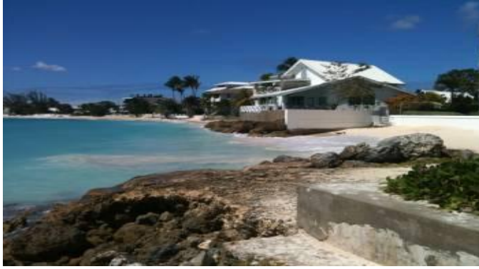
Φωτογραφία 26 Παραλιακό σπίτι στη Νότια ακτή στο Sandy beach. Είναι εμφανές ότι δεν τηρείται ο κανόνας των 30 μέτρων
