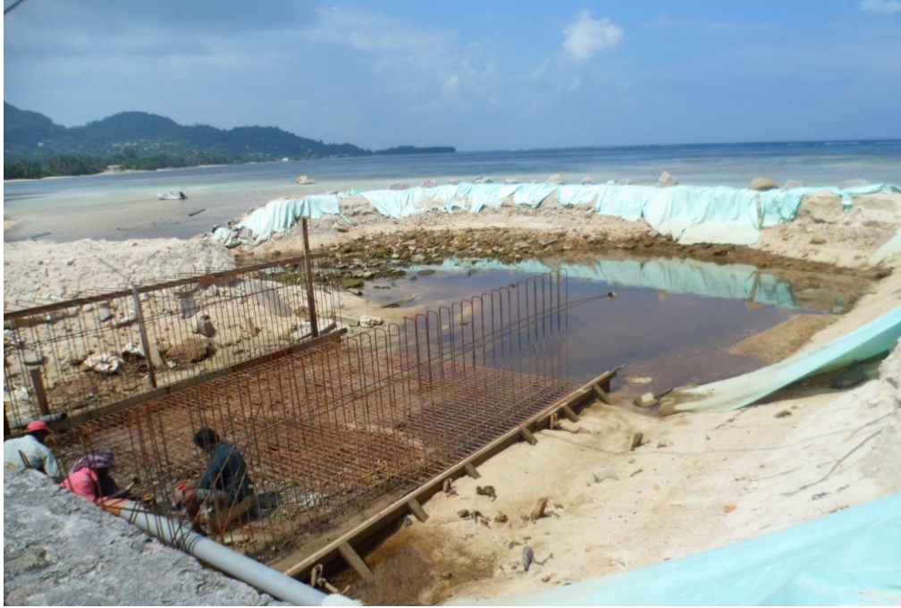
Φωτογραφία 63 Κατασκευή Αγωγού Όμβριων Υδάτων
