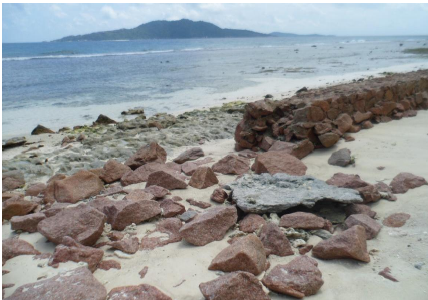
Φωτογραφία 66 Αποτυχημένη Προσπάθεια Προστασίας της Ακτογραμμής στο νησί La Digue
