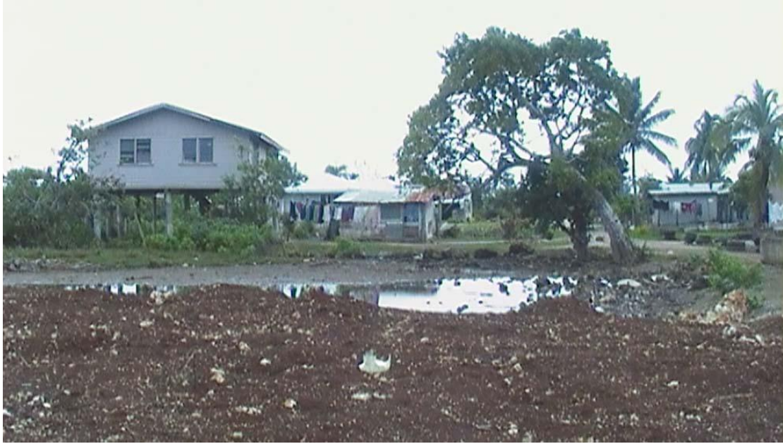
Φωτογραφία 20 Σπίτια σε Πασσάλους στη Ρορνα για την Προστασία από την Άνοδο της Στάθμης της Θάλασσας
