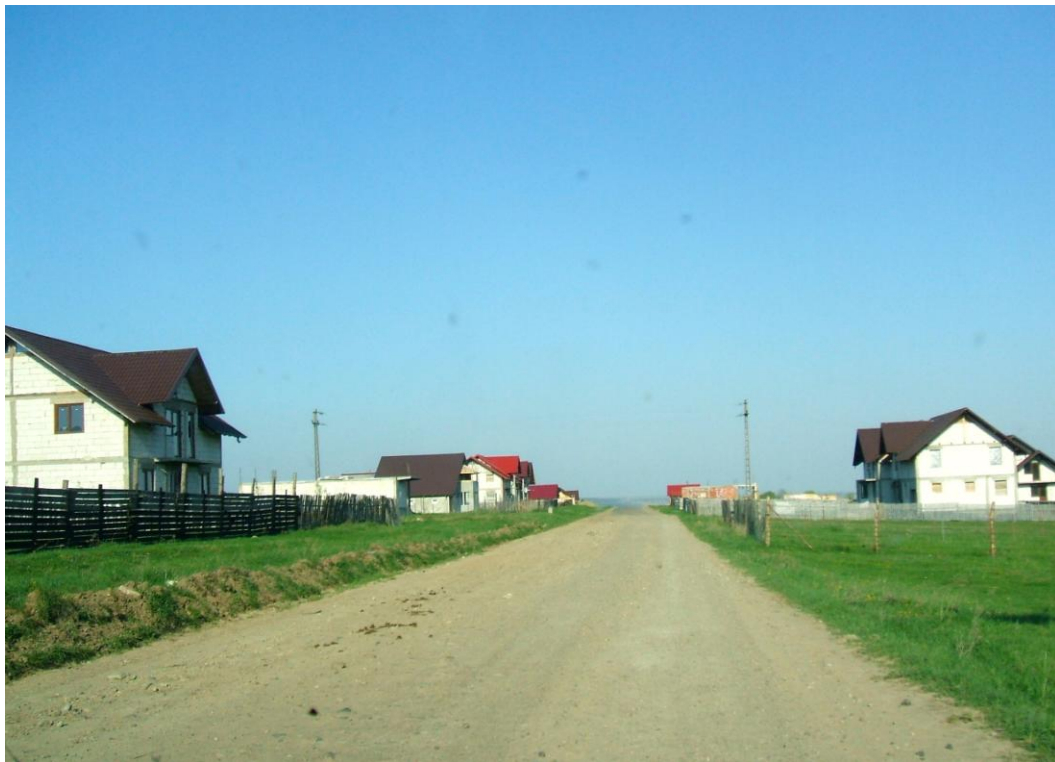
Σπίτια συνεντευξιαζόμενων υπό κατασκευή – νομός Suceava
