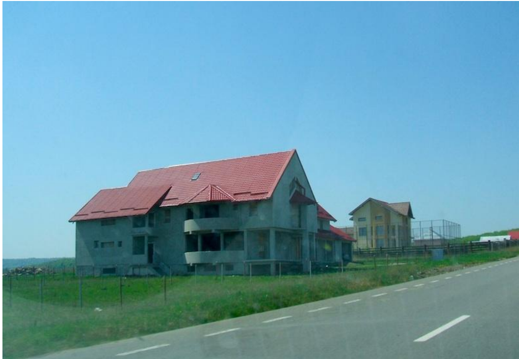
Σπίτια συνεντευξιαζόμενων υπό κατασκευή – νομός Botosani
