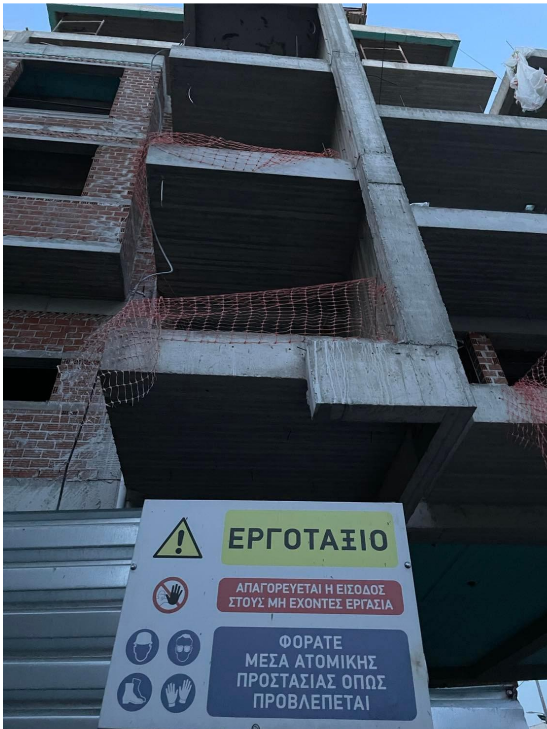
Εικόνα 7. Μέτρα Ασφαλείας στο εργοτάξιο
