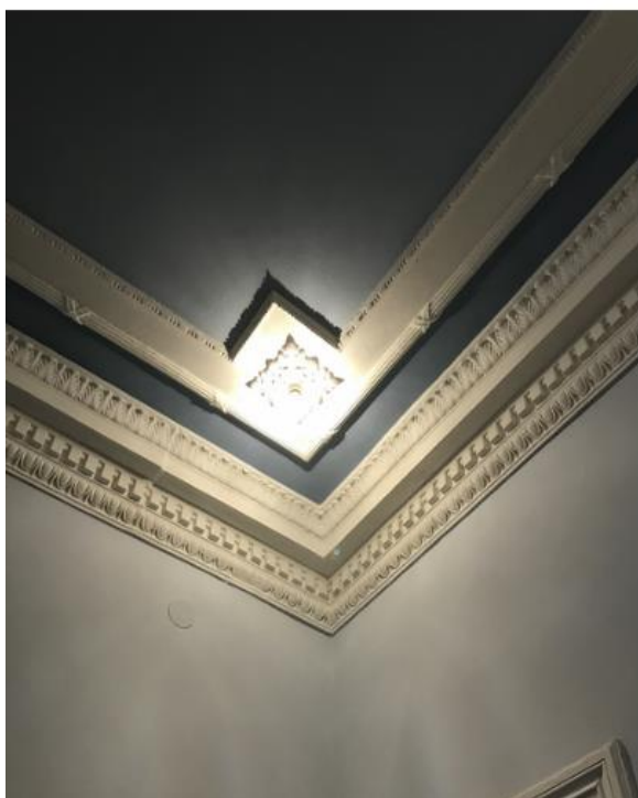
Εικόνα 40,41,42,43: Από αριστερά προς δεξιά: λεπτομέρεια γύψινου διάκοσμου οροφής δωματίου τραπεζαρίας και καθιστικού - εικόνες κατόπιν της αποκατάστασης του κτιρίου το 2020. Οι τοίχοι και οι οροφές έχουν υποστεί ελαιοχρωματισμό σε απόχρωση άλλη από την αρχική της κατοικίας.
