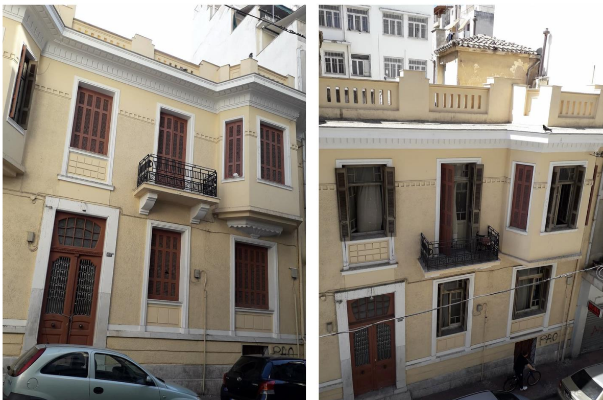
Εικόνα 18: Πρόσοψη κατοικίας επί της οδού Αγαθουπόλεως 65 Α.
