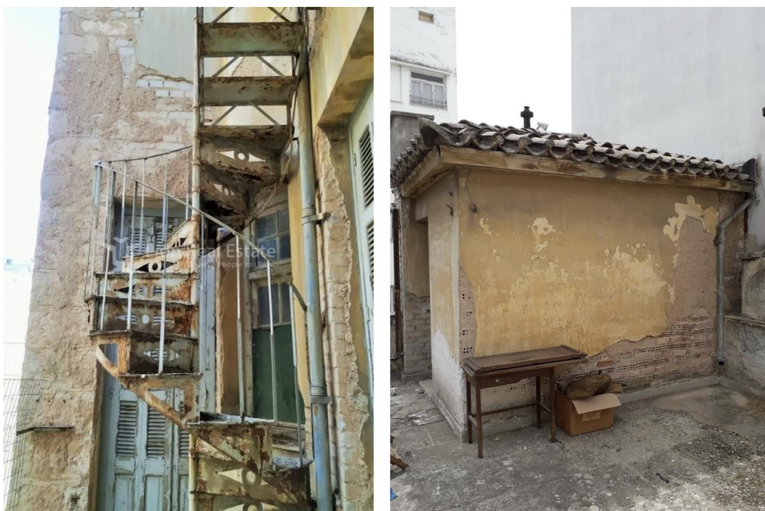
Εικόνα 27,28: εξωτερική μεταλλική σκάλα οικιακού προσωπικού και δωμάτιο δόματος
