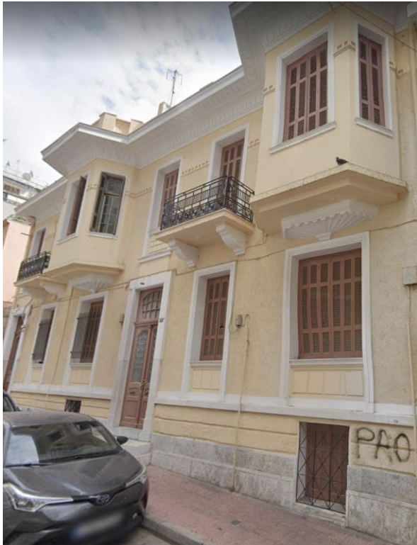
Εικόνα 1: Σημερινή πρόσοψη των κατοικιών στην οδό Αγαθουπόλεως 65 και 65 Α
