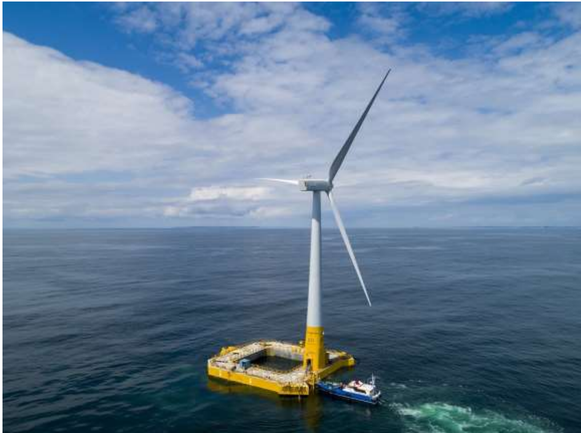
Εικόνα 4: Μεταφορά πλωτής ανεμογεννήτριας στον τόπο εγκατάστασης του υπεράκτιου ΑΣΠΗΕ «Floatgen».
