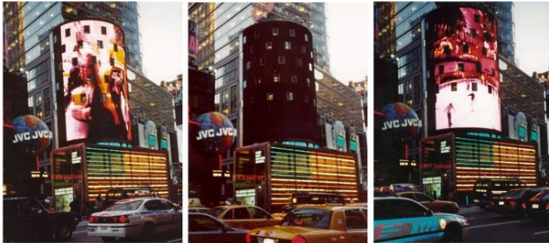
Εικ. 1: Το κτίριο NASDAQ, Times Square, Νέα Υόρκη
