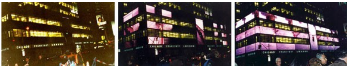
Εικ. 2: Times Square, Νέα Υόρκη: Μεταβολή της όψης του κτιρίου, από στατική μάζα (αριστερά) μετατρέπεται σε δυναμικά μεταβαλλόμενο χώρο (δεξιά)
