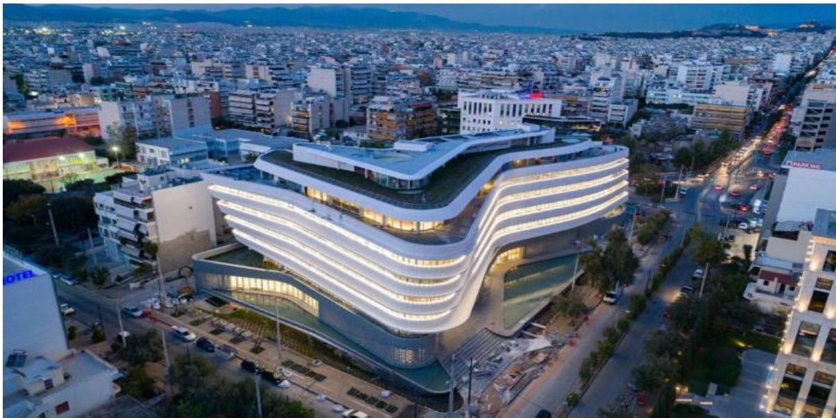
Εικόνα 11: Κτίριο Γραφείων Ομίλου Anangel Maritime Group. Πηγή: (insider, 2018)
