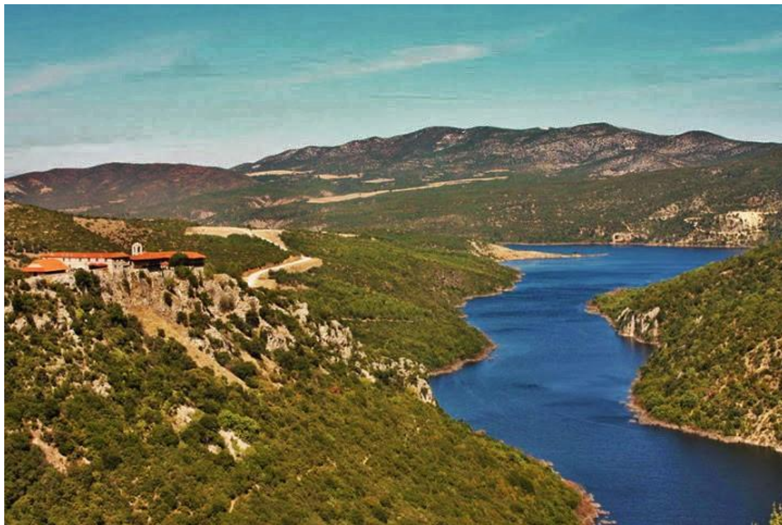
Εικόνα 10 - Μοναστήρι Ζάβορδας και Αλιάκμονας Ποταμός μετά την κατασκευή του φράγματος του Ιλαρίωνα
