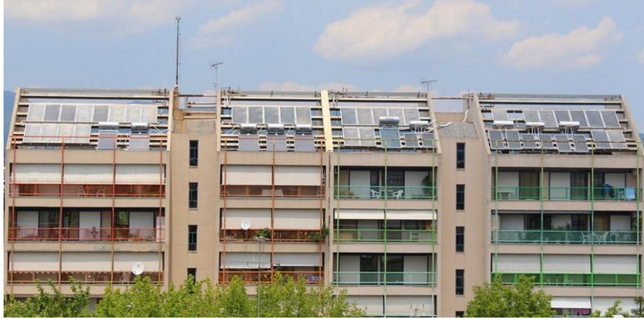
Εικόνα 27. Κτίρια από το Ηλιακό Χωριό όπου διακρίνονται ηλιακοί θερμοσίφωνες ανάμεσα στους ηλιακούς συλλέκτες που δεν λειτουργούν 132
