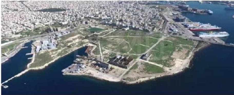
Εικόνες 37 και 38. Όψεις της περιοχής που καταλάμβανε το Συγκρότημα Λιπασμάτων και Χημικών Προϊόντων πριν και μετά την κατεδάφιση του μεγαλύτερου μέρους του 140
