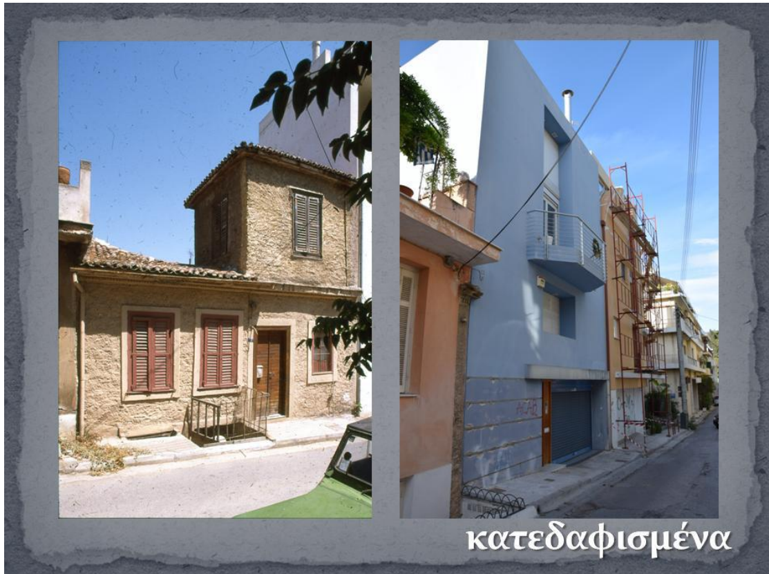
Φωτο: Αντικατάσταση του παλιού κτιριακού αποθέματος από το νέο.
