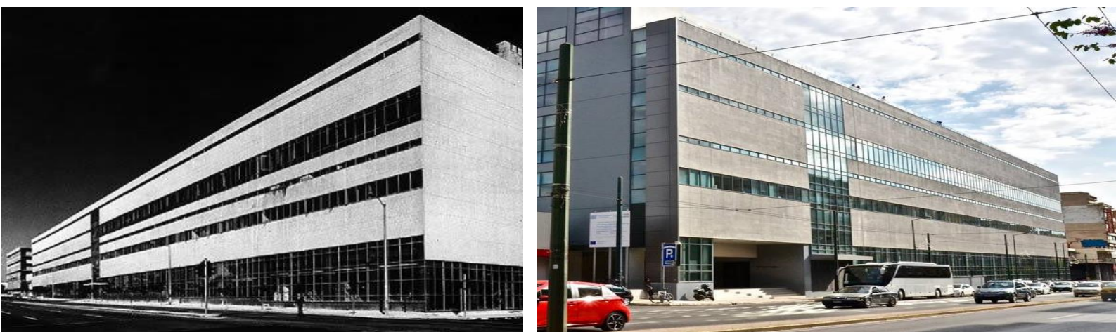
Εικόνα 9 Αναπαλαίωση εξωτερικού κελύφους και εσωτερικών χώρων κτιρίου ΦΙΞ, Αθήνα
