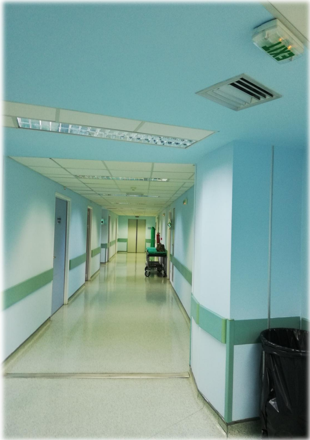
Φωτογραφία 8. «Καθαρή ζώνη»: Διάδρομος
