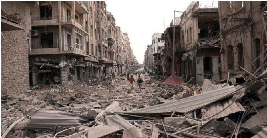
Εικόνα 2.23 Καταστροφές κτιρίων στο Χαλέπι κατά τον συριακό εμφύλιο
