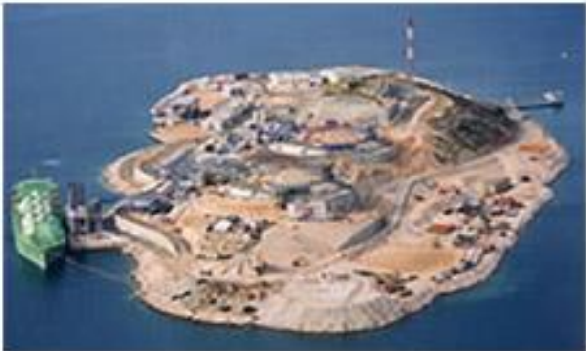
Εικόνα 2: Εγκαταστάσεις φυσικού αερίου στη νήσο Ρεβυθούσα
