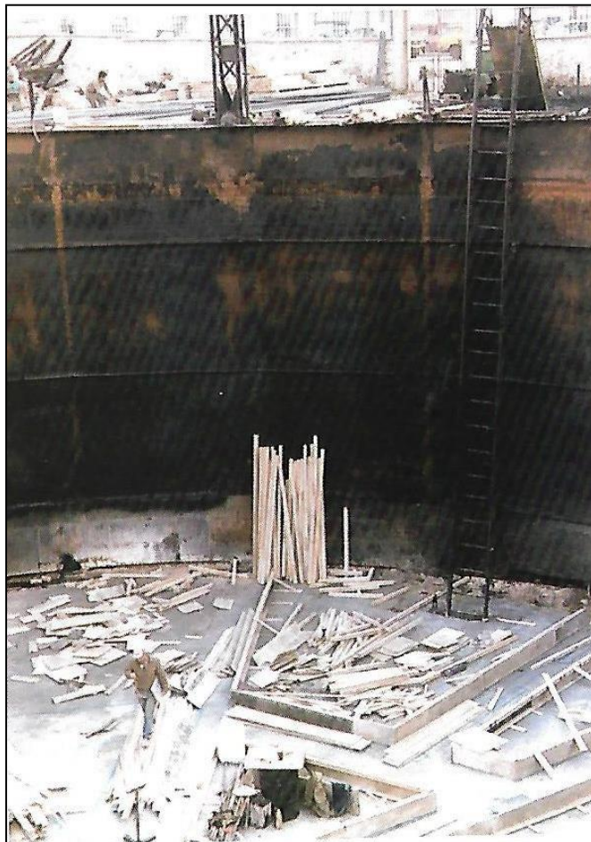
Εικόνα 51: Εργασίες αφαίρεσης της μεταλλικής δεξαμενής του Αεριοφυλακίου 1, τέλη δεκαετίας 1990.
