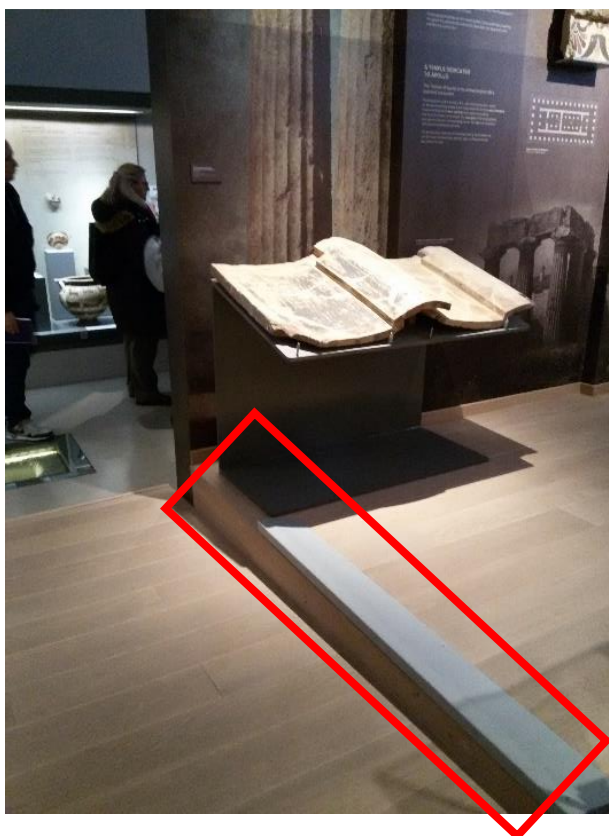
Εικόνα 34: Τοποθέτηση ράμπας ασφαλείας στο πάτωμα (με γκρι χρώμα)
