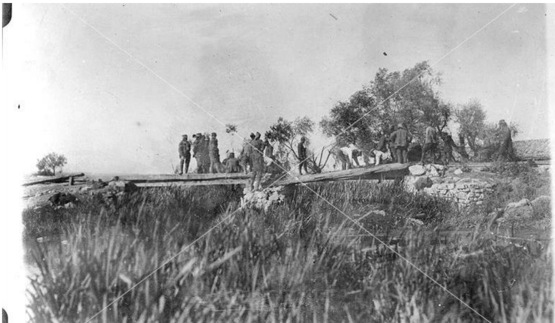
Μικρασιατικό Μέτωπο. ΙΙΙ Μεραρχία. Η προέλαση του ελληνικού στρατού προς την Άγκυρα. Οπλίτες κατασκευάζουν την κατεστραμμένη πρόχειρη γέφυρα για τη διάβαση του ποταμού Γκεούκ στο Μέτωπο του Σαγγαρίου. ΕΡΤ ΑΕ Αρχείο/ Μουσείο: www.ert-archives.gr .
