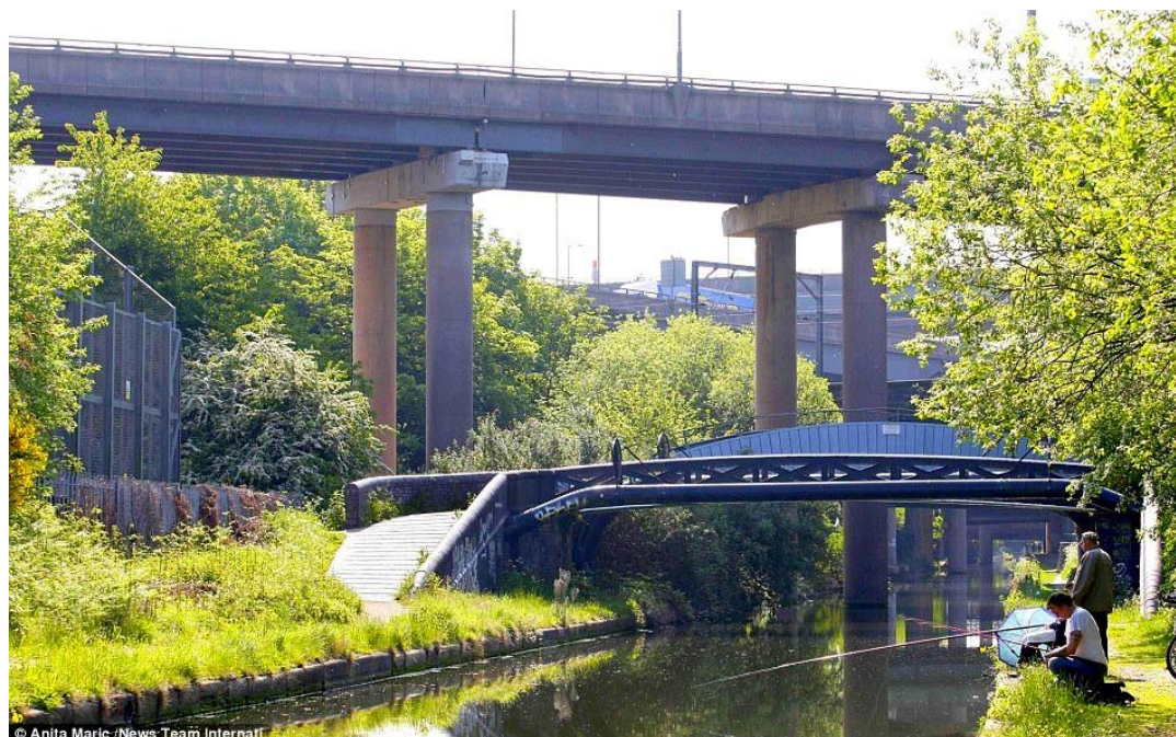
E-27. Υπερυψωμένος αυτοκινητόδρομος στο Birmingham
