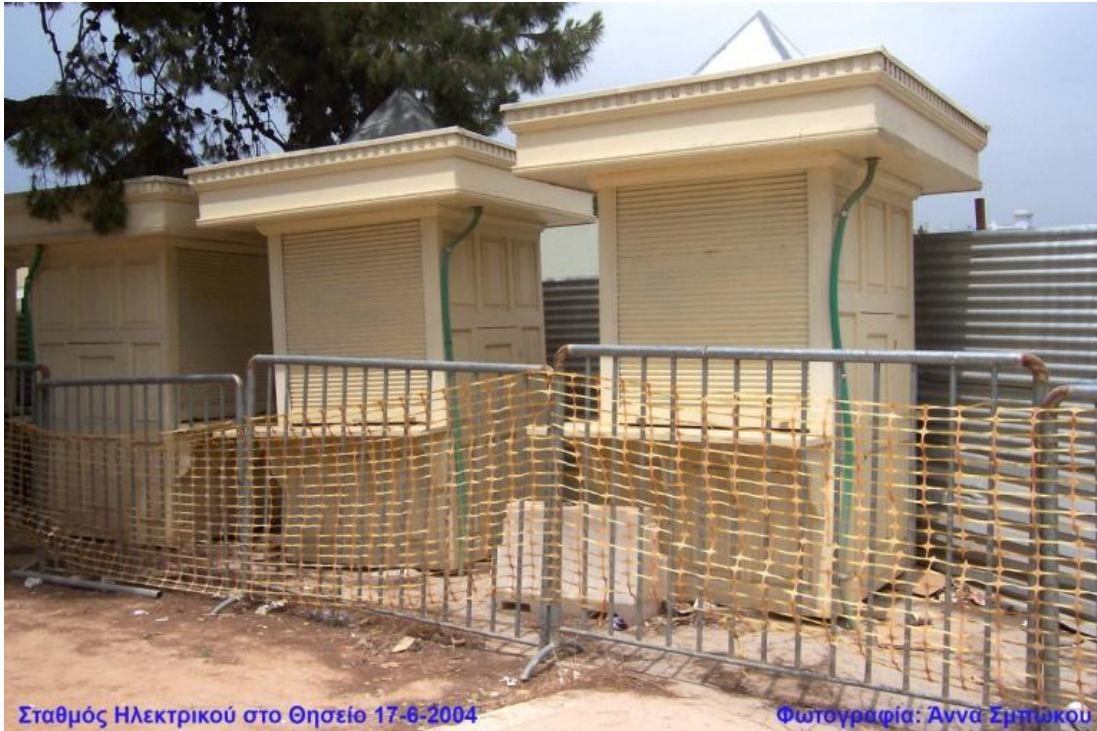
E-7. Σταθμός Ηλεκτρικού στο Θησείο, 17-6-2004
