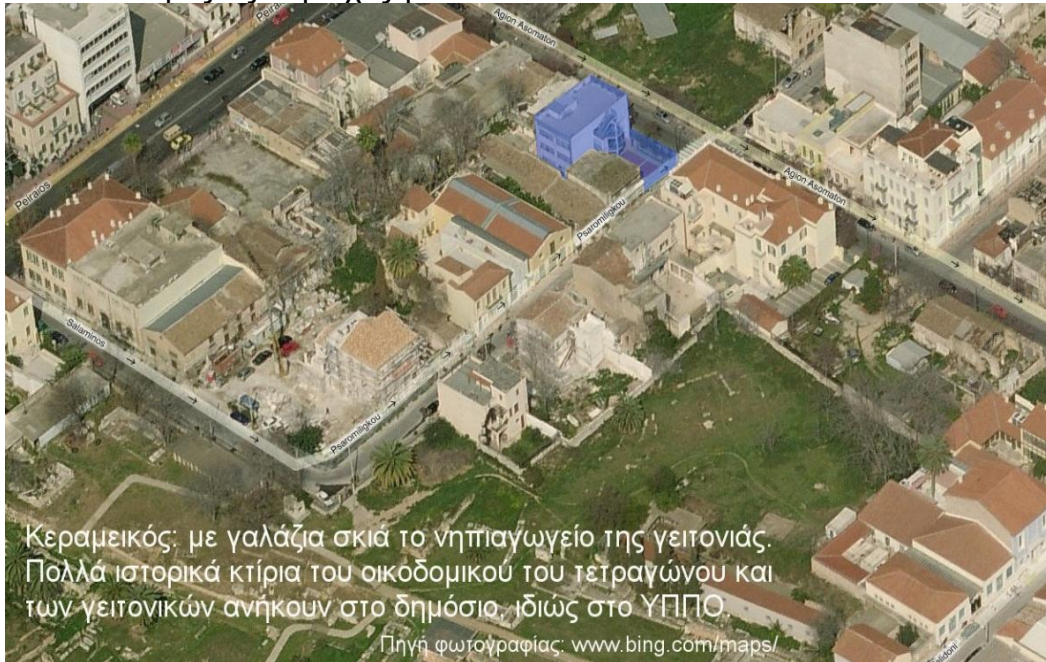
X-14. Περιοχή οδού Αγ. Ασωμάτων.
