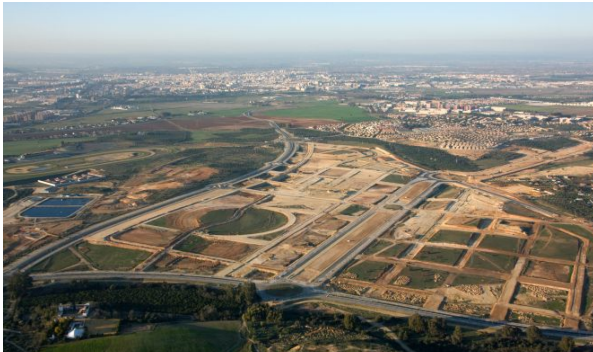
Η έκταση που προορίζεται για την κατασκευή του έργου
