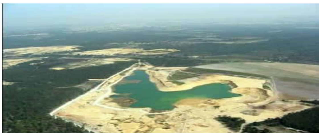
Η έκταση που προορίζεται για την κατασκευή του έργου
