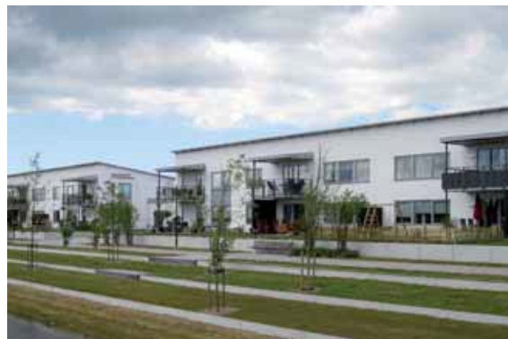
Εικόνα 3.6: Helsingborg, Σουηδία, έργο ECO-City, Πηγή: Energy Solutions for Smart Cities and Communities, 2014
