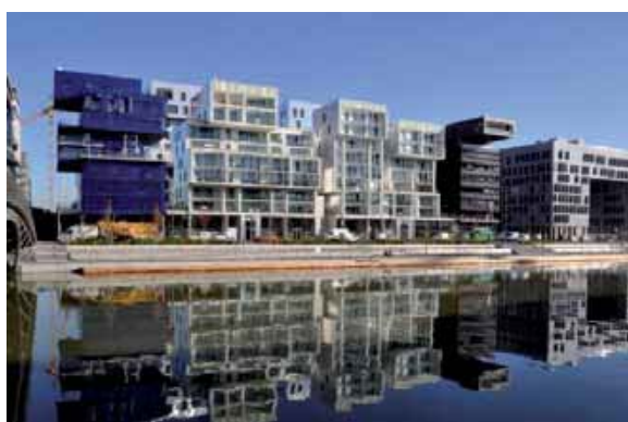
Εικόνα 3.7: Lyon, Γαλλία, έργο RENAISSANCE, Πηγή: Energy Solutions for Smart Cities and Communities , 2014
