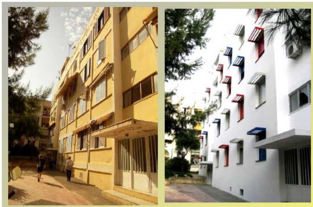
Εικόνα 2.4: Το κτήριο επί της οδού Σίφνου πριν και μετά τις παρεμβάσεις του έργου, Πηγή: ΚΑΠΕ
