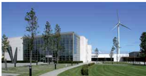
Εικόνα 3.3: Χρήση αιολικής ενέργειας, Dundalk, IR, έργο HOLISTIC, Πηγή: Energy Solutions for Smart Cities and Communities , 2014
