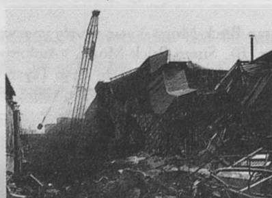
Derribo en Barcelona. Demolition in Barcelona, 1997
