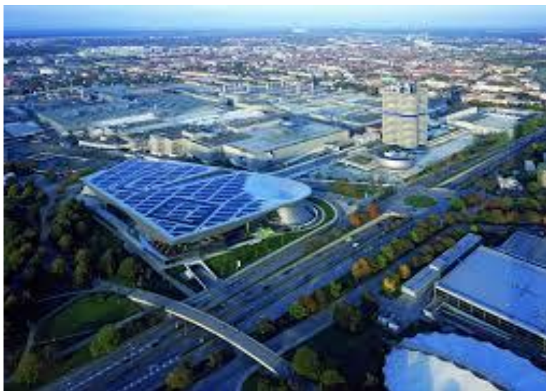
Εικόνα 10 :Φωτοβολταϊκά σε στέγη κτιρίου(Google)
