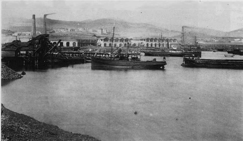
Εγκατάσταση εκφόρτωσης αρχαίων μολυβδόχων σκωριών Ε.Ε.Μ.Α.
