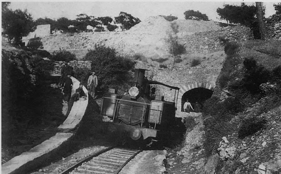
Η πρώτη σιδηροδρομική σήραγγα της Ελλάδας, μήκους 265,25 μ. στην Καμάριζα και σιδηρόδρομος της Ε.Ε.Μ.Α.
