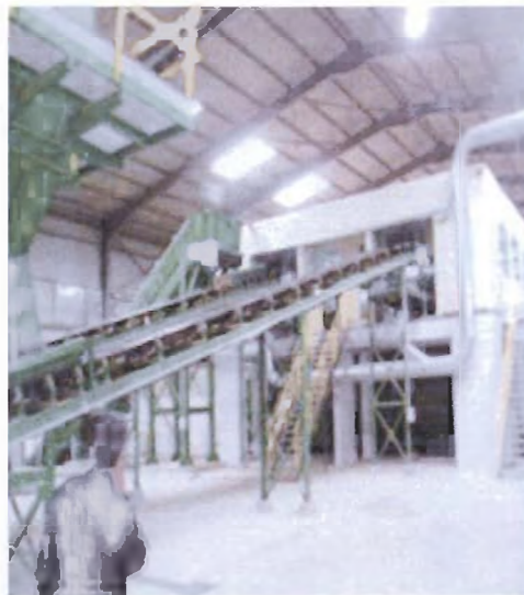
Σχέδιο 3,1: Άποψη εγκαταστάσεων που απαιτούνται για τον διαχωρισμό των αστικών απορριμμάτων, φωτο από ΚΔΑΥ Χανίων 121 .
