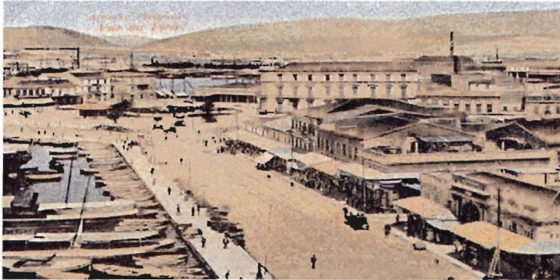
Εικόνα 54: Δημόσια κτίρια, κατοικίες, εργοστάσια και άνθρωποι σε αρμονική συνύπαρξη στον Πειραιά της νεοκλασικής περιόδου (Αρχείο Σπ. Μανουσάκη) (Καθημερινή « Επτά Ημέρες» 30 Απριλίου, 1995)
