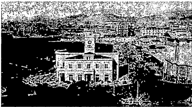
Εικόνα 50: Σταθμός ΗΣΑΠ ( Πειραικό Λεύκωμα, 2002)
