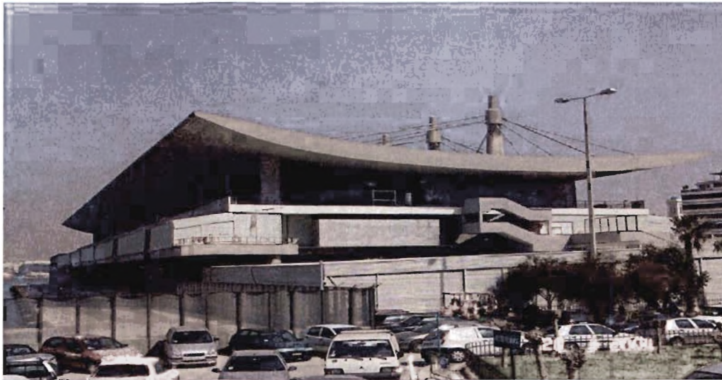
Εικόνα 72: Το κτίριο του Συνεδριακού Κέντρου του ΟΛΠ
