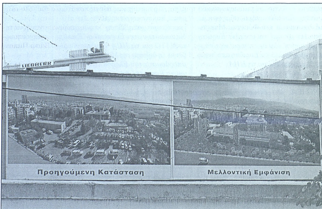
«Προηγούμενη Κατάσταση»: Όπως στη φωτογραφία. Παρούσα κατάσταση και εμφάνιση: Κατασκευή σκελετού μπετόν-αρμέ. «Μελλοντική Εμφάνιση»: Κάπως όπως στη μακέτα. «Μελλοντική Κατάσταση»;
