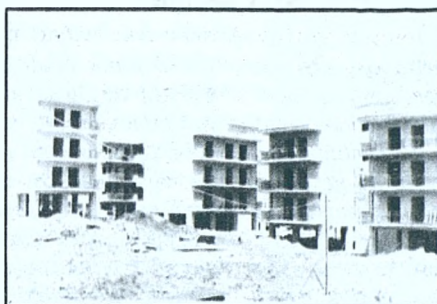
Οι υπό ανέγερση εργατικές πολυκατοικίες θα βοηθήσουν στη λύση του στεγαστικού προβλήματος στο Αγρίνιο.
