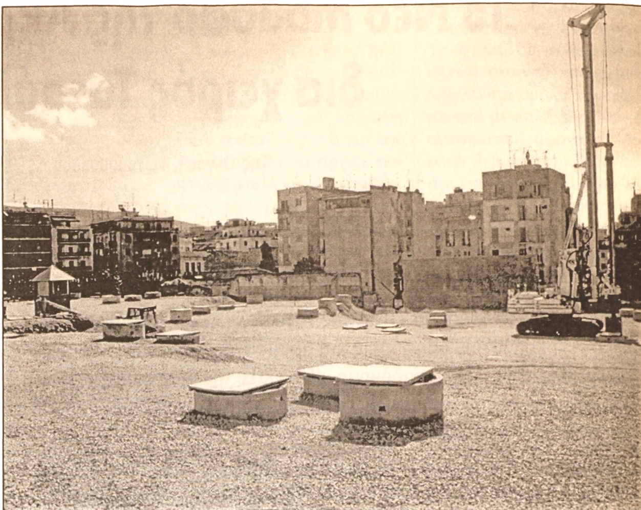
Νοέμβριος 2004: Η αρχαιολογική ανασκαφή έχει καλυφθεί προσωρινά, οι κατεδαφίσεις των γύρω κτηρίων συνεχίζονται και οι «εργασίες προετοιμασίας» για το χτίσιμο του Νέου Μουσείου έχουν αρχίσει – αν και παράνομα...
