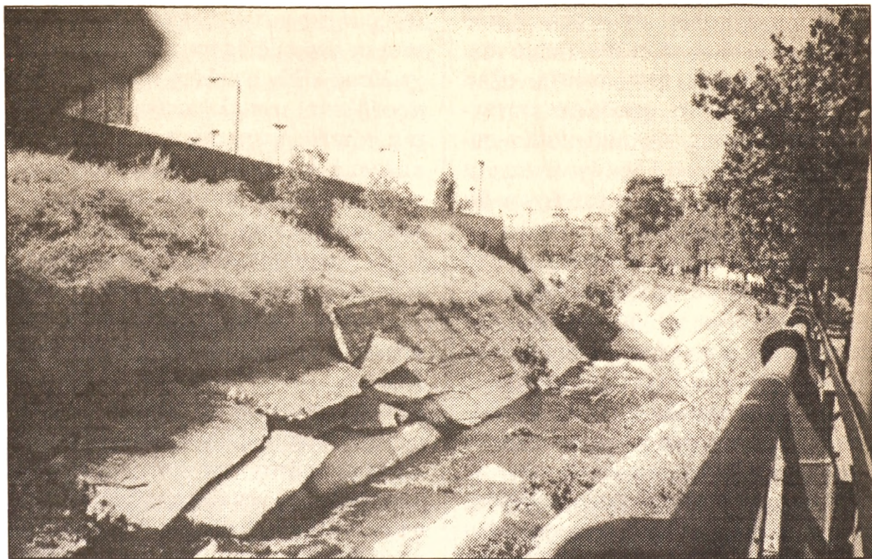
Διαβρωμένα τα πρανά του Κηφισού κάτω από την Εθνική οδό. Τα μεγάλα κομμάτια από σπασμένο μπετόν θα παρασυρθούν σε λίγο μέσα στην κοίτη του Κηφισού και θα τον φράξουν.
