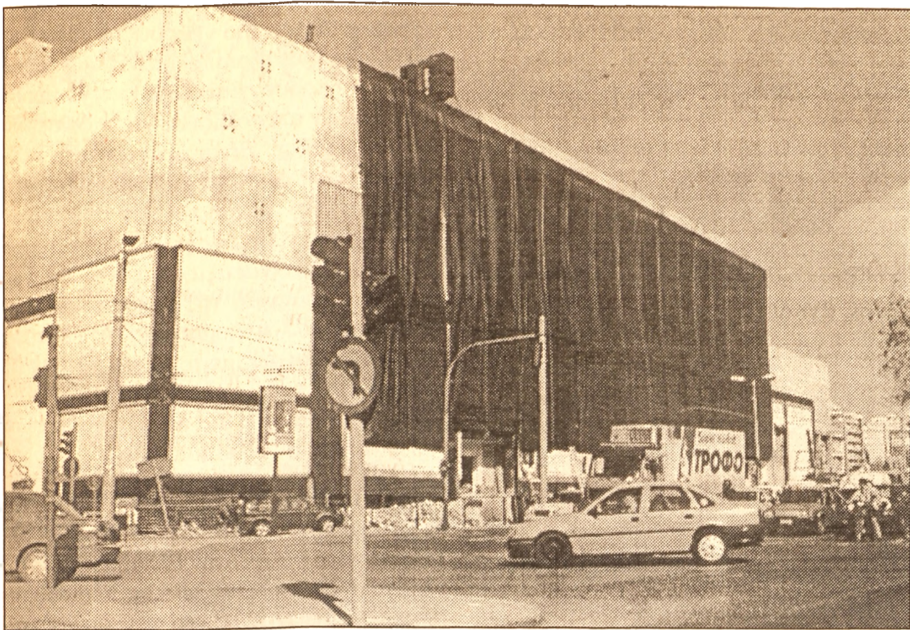
Το εργοστάσιο Φιξ όπως φαίνεται από την οδό Καλλιρρόης. Ένα στάδιο πριν την έκθεση Τσαρούχη.
