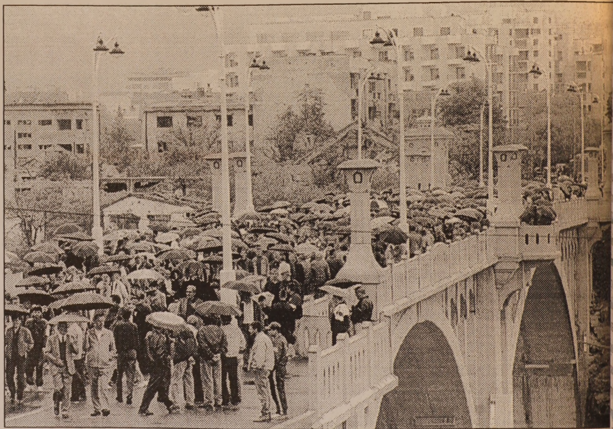
Εκατοντάδες άνθρωποι περνούν την νεοχτισμένη γέφυρα Καρίνσι που ενώνει το δυτικό με το ανατολικό Μόσταρ.
