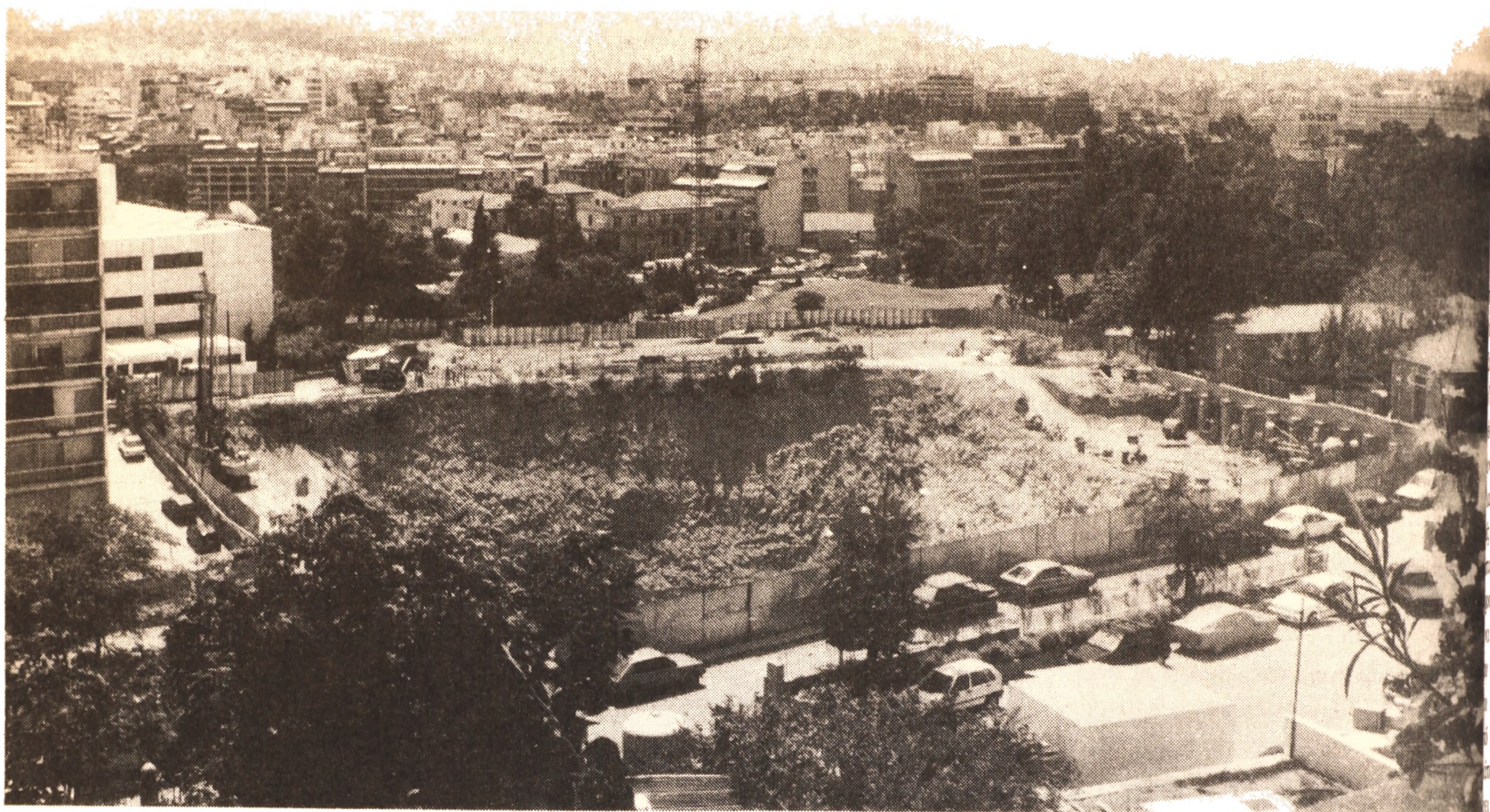
Πρόσφατη φωτογραφία από το εργοτάξιο των Λαμπράκη-Πανδή: Τα μεγάλα σκαπτικά μηχανήματα εν δράσει στο παρκάι. Δεξιά, προχωρεί η κατακόρυφη εκσκαφή στην περιοχή ανέγερσης της Όπερας, η οποία θα πνίξει τα υπάρχοντα κτίσματα του πολιτιστικού κέντρου του Δήμου της Αθήνας (κτίρια της ΕΑΤ/ΕΣΑ). Αριστερά εμφανίζεται το σκαπτικό μηχανήμα που προχωρεί δίπλα στη -μη απαλλοτριωθείσα πάντως- πολυκατοικία του ΑΟΟΑ..
