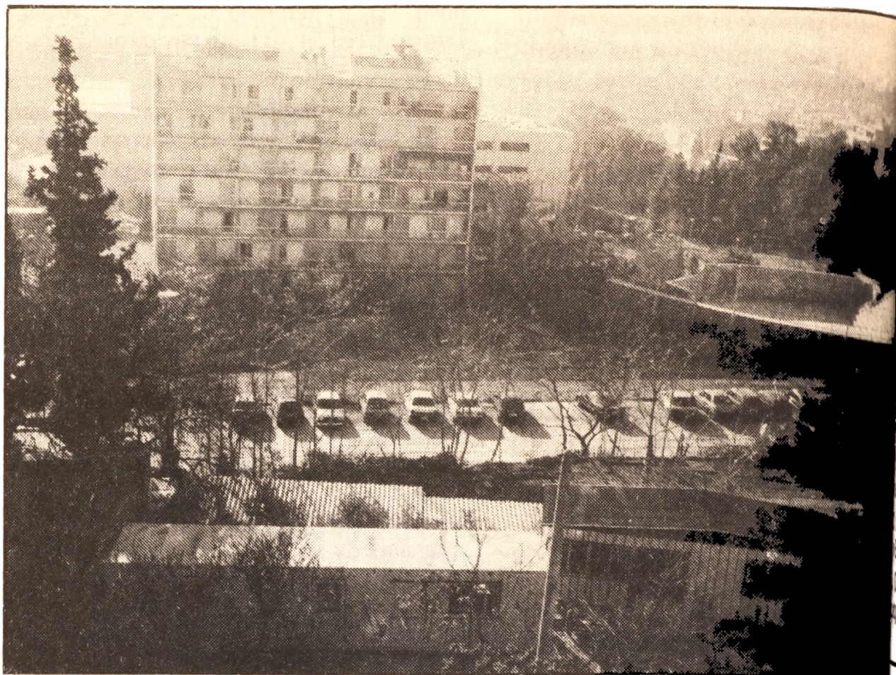
Το υπαίθριο θεατράκι θα γκρεμιστεί και όλος ο χώρος θα εκσκαφεί σε βάθος 18 μέτρων!
