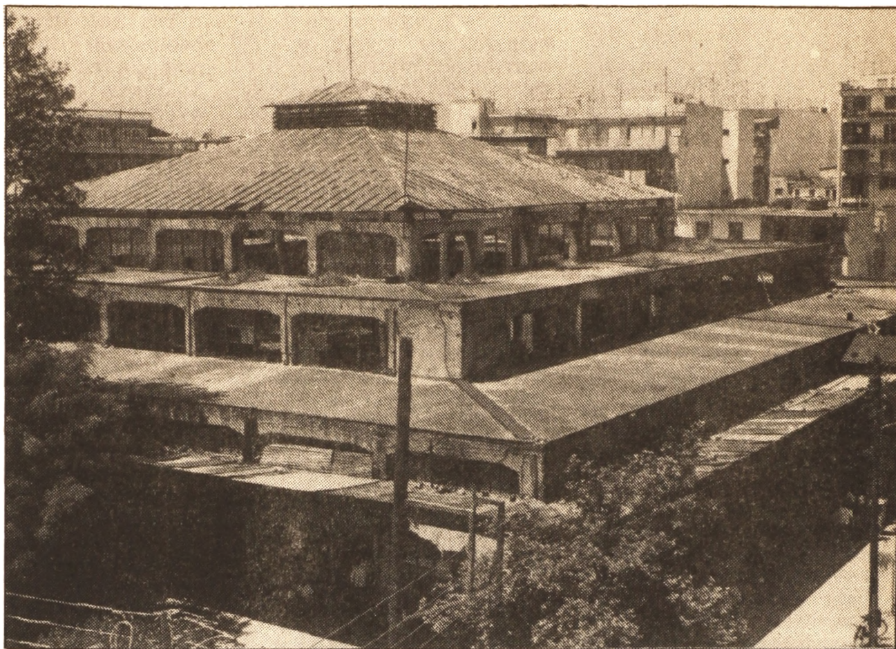
Όψη του κτιρίου της Δημοτικής Αγοράς
