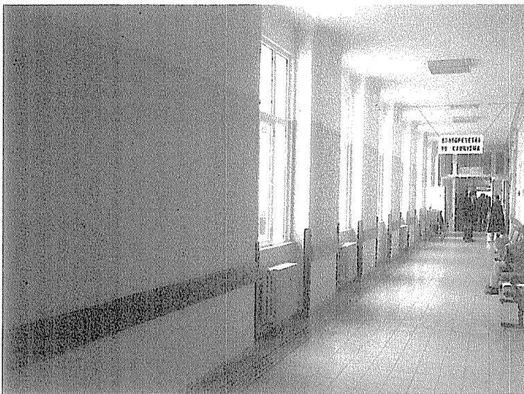
ΦΩΤΟ 36 : Ισόγειο. Διάδρομος προς τα εξωτερικά ιατρεία.
