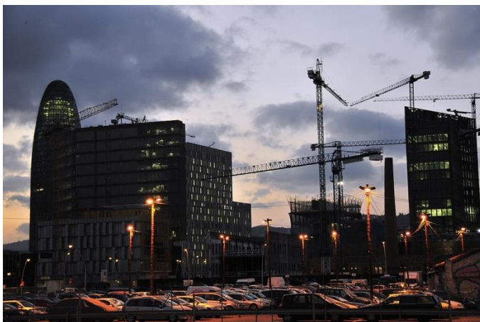
Εικόνα 8. Άποψη της κατασκευής στο Poblenou, της Βαρκελώνης που προκύπτει από το σχέδιο 22@Barcelona. Πηγή: https://en.m.wikipedia.org/wiki/
