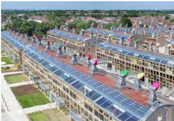
Φωτ.1: οικισμός BEDZED
