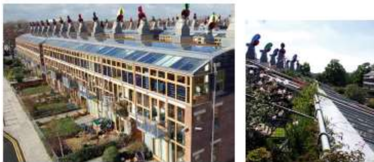
Φωτ.2,3: ιδιωτικοί κήποι και φυτεμένα δώματα κατοικιών στο BEDZED
