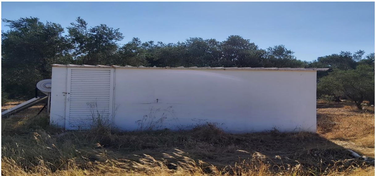
Εικ. 4 Χώρος πλυσίματος σορών Κοιμητηρίου του Κάτω Τρίτος Λέσβου, φωτογραφία της συγγραφέως, 17/07/2022.
